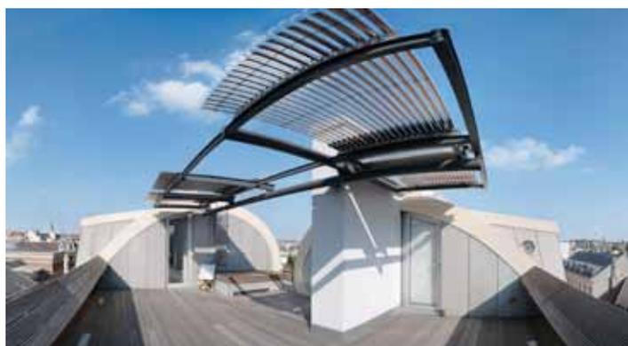
Capteurs solaires à tubes sous vide à passage direct Vitosol 200-T. Prix public indicatif de 1.849 euros HT et hors pose (modèle 2 m<sup>2</sup>).
